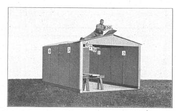
Abb. 5. Verlegen der Firstplatten.
