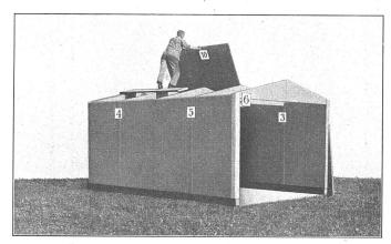
Abb. 4. Verlegen der Dachschalung.
