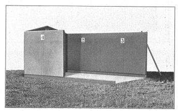
Abb. 1 und 2. Veranschaulichung der allmählichen Aufstellung der Seitenwände, die je nach Grösse aus 1-2 Teilen von 2,4 oder 3,6 m Breite bestehen. Die Wandstücke sind dicht ineinander zu schieben, wobei darauf zu achten ist, dass die Eisenverankerungen mit den Löchern im Sockel übereinstimmen.
