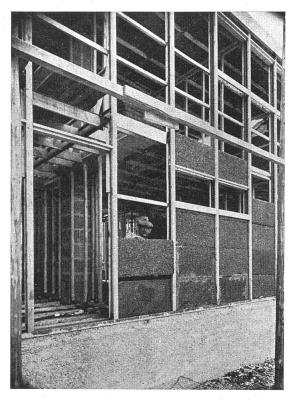
**DETAILAUFNAHME GROPIUS**Eisenkonstruktion mit Verlattung. Korkplatten mit doppelseitiger Eternitisolierung
