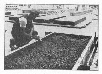
Abb. 3. Einlegen der Eisenhaken zum Hochwinden der Platten
