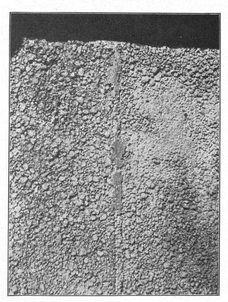
Abb. 5. Ansicht einer unbearbeiteten Stossfuge
