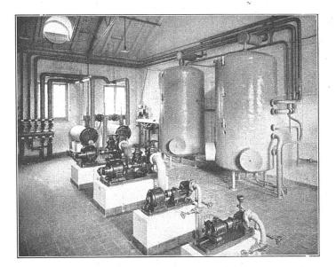
Zentrale einer Sulzer-Pumpenheizung und Warmwasserbereitung in einem Krankenhaus
