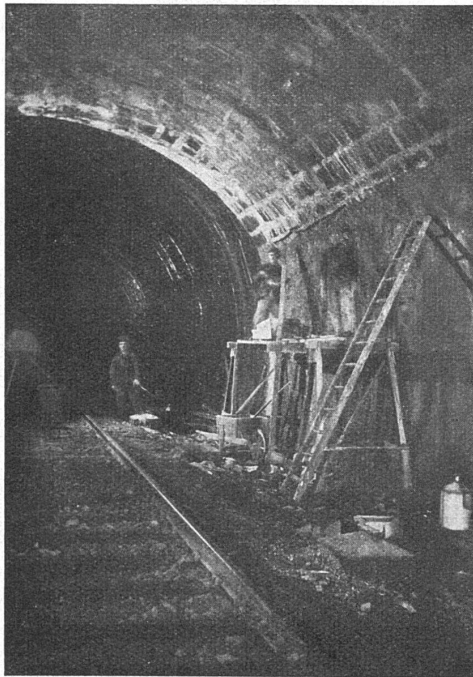
Abb. 12. Abdichtung des Tunnels Aue der deutschen Reichsbahngesellschaft während des Wasserdruckes mit Sika .
