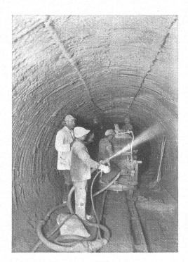
Abb. 13. Stollenauskleidung mit Sika beim Gross-Kraftwerk Partenstein (Oberösterreich).
