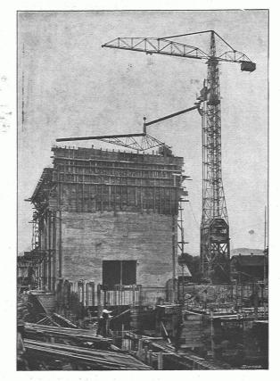
Abb. 2. Turmdrehkrananlage der Firma Grüring-Dutoit, Söhne & Cie. Biel, mit Betonschüttvorrichtung beim Bau des Maschinenhauses des Kraftwerkes Wäggital in Siebnen
