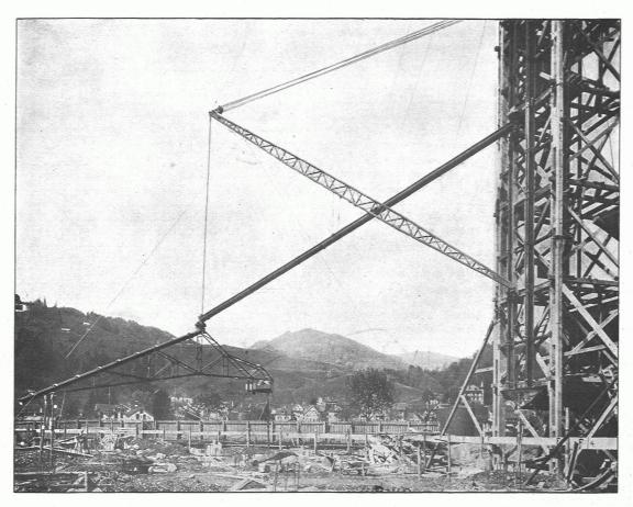
Abb. 3. Feststehende Betonschüttanlage der Firma Grüring-Dutoit, Söhne & Cie., Biel
