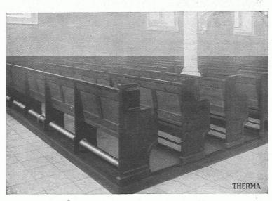
Abb. 1. Fussbankheizung. Unter der hintersten Bankreihe ist das Heizrohr sichtbar, unter den vordern Reihen sind die Rohre durch Holzlatten verdeckt.
