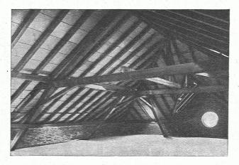
Eternit=Unterdach unter Ziegeldachung Feuersicher, grosser Schutz gegen Feinschnee und Staub
