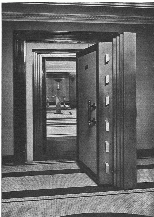
Abb. 2. Die Panzertüre zum Saferraum. Ausführung der Firma A. & R. Wiedemar, Bern.
