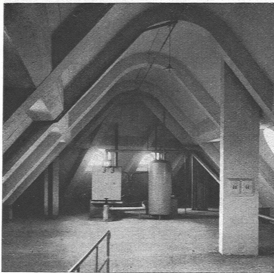
Abb. 5. Dachboden mit Niederdruck-Kaltwasserreservoir. Aufgestellt von der Firma J. Rothmayr, Zürich, und dem Expansionsgefäß der von Gebrüder Sulzer A.-G. ausgeführten Pumpen-Warmwasserheizung.
