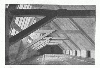
Feuersicherer Ausbau eines Dachstuhles mit Eternit-Platten
