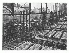
Abb. 7. Armierungsarbeiten der Zwischendecken und Fassadenpfeiler.
