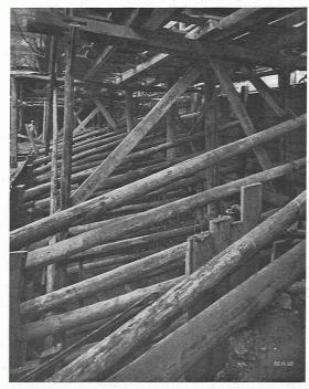
Abb. 1. Abspriessen der Erdwände gegen die Bahnhofstrasse.
