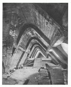
Abb. 6. Dachkonstruktion in armiertem Beton.
