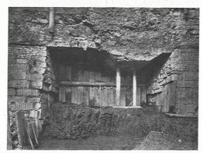
Abb. 2. Unterfangen der höherliegenden Fundamente des St. Annahofes.
