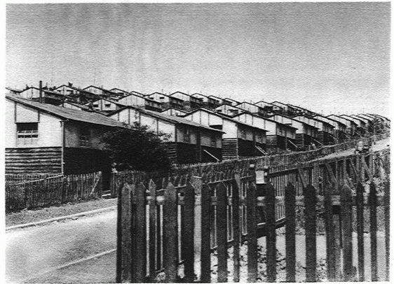
MUNITIONSARBEITER-SIEDELUNG WELL HALL ZU ELTHAM, KENT Building Departement Woolwich Arsenal / Grundriss siehe Seite 225 / Holzkonstruktion, Eternitwände, Teerpappedach
