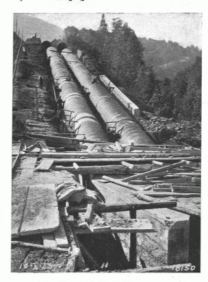
Abb. 2. Sulzer-Druckleitungen von 2500/2200 mm Durchmesser und 816 m Länge bei 195 m Gefälle vom Rempen-Staubecken zur Zentrale Siebnen.
