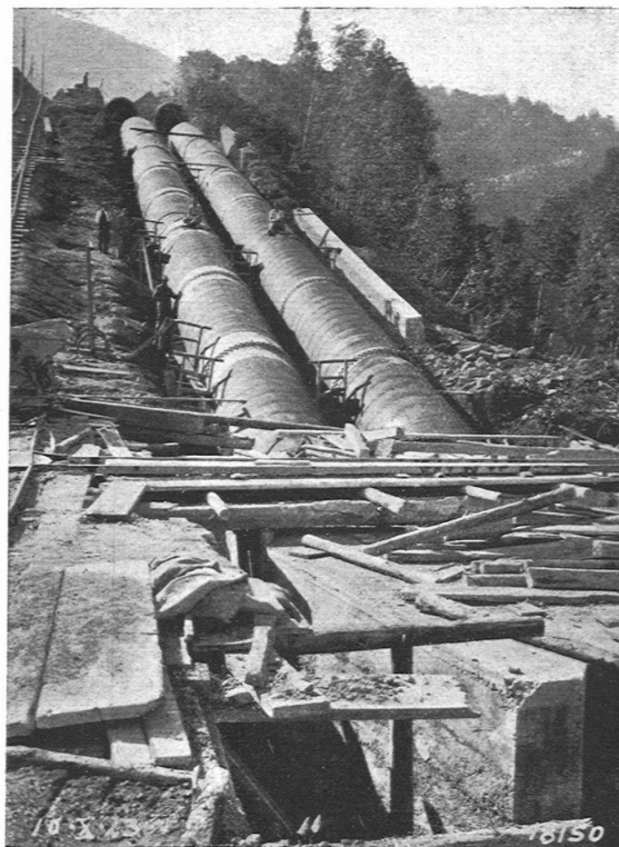
Abb. 2. Sulzer-Druckleitungen von 2500/2200 mm Durchmesser und 816 m Länge bei 195 m Gefälle vom Rempen-Staubecken zur Zentrale Sieben.
