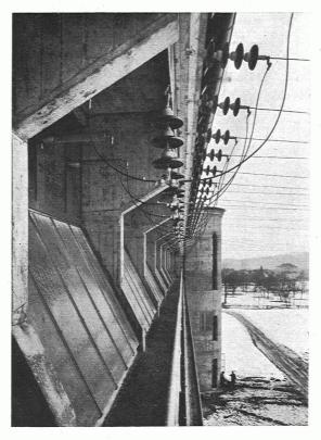
Abb. 2. Von der Zentrale Siebnen abgehende, mit Langenthaler Isolatoren ausgerüstete Übertragungsleitungen.
