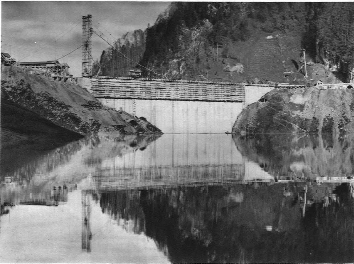
14. STAUMAUER SCHRÄH VON DER WASSERSEITE, ZWEI TAGE VOR IHRER VOLLENDUNG AM 30. OKTOBER 1924
