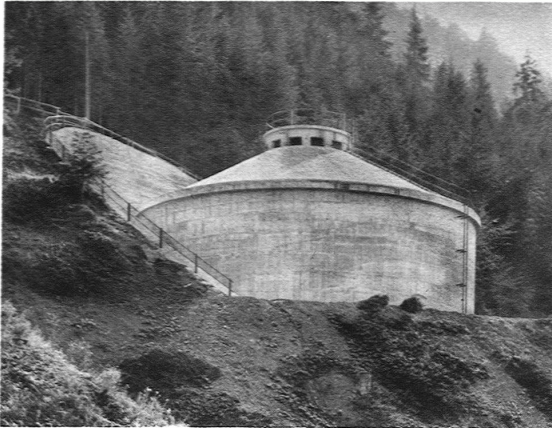
17. ZYLINDRISCHER WASSERBEHÄLTER DES WASSERSCHLOSSES REMPEN
