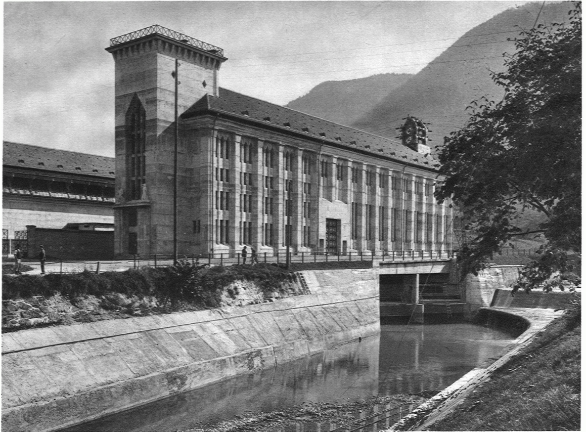
27. ZENTRALE SIEBNEN / MASCHINENHAUS / KANAL DER AA ARCHITEKTEN GEBR. BRÄM B.S.A.
