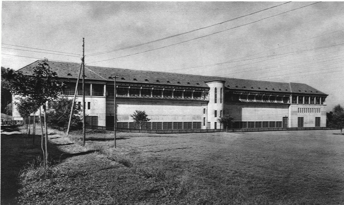
30. ZENTRALE SIEBNEN / SCHALTHAUS, RÜCKSEITE ARCHITEKTEN GEBR. BRÄM B.S.A.
