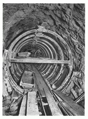
16. BETONAUSKLEIDUNG DER DRUCKSTOLLEN MITTELS EISERNER SCHALUNG
