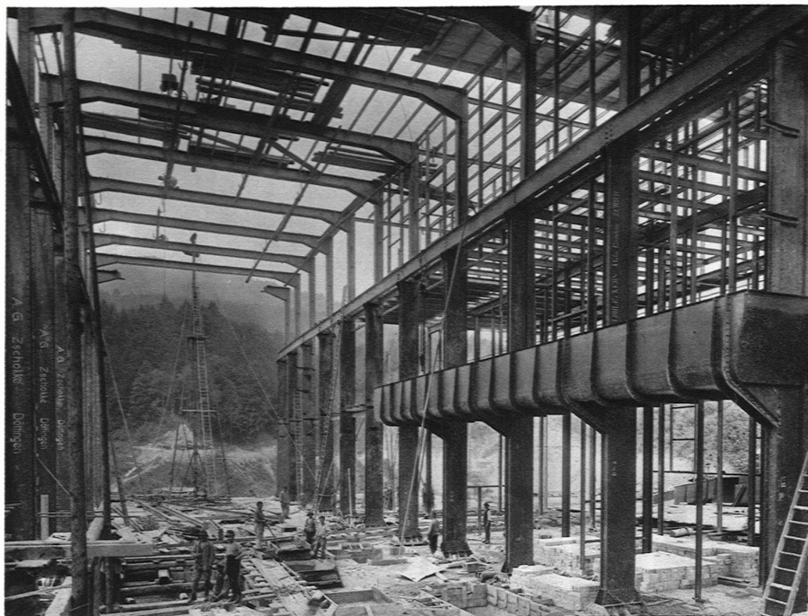
42. MASCHINENHAUS REMPEN / MONTAGE DES EISENHOCHBAUES
