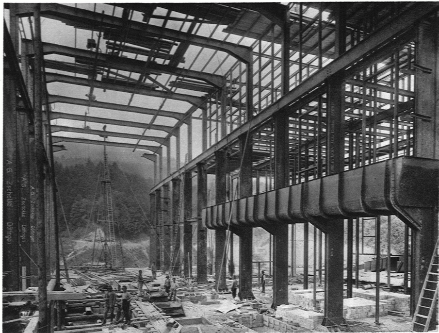
42. MASCHINENHAUS REMPEN / MONTAGE DES EISENHOCHBAUES
