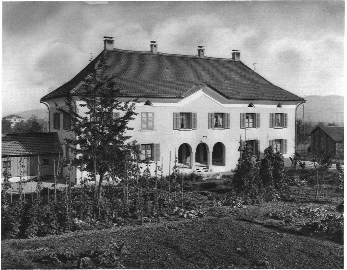
37. WOHNKOLONIE SIEBENEN / ARCHITEKTEN GEBR. BRÄM B.S.A., ZÜRICH MEHRFAMILIENHÄUSER BLOCK A UND B
