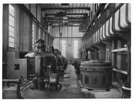
43. MASCHINENSAAL REMPEN / INNERES Vier Generatoren und vier Pumpenmotoren, wovon zwei montiert
