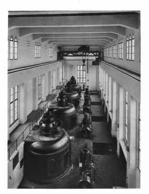
32. ZENTRALE SIEBNEN / MASCHINENHAUS Saal mit 4 Einheiten zu 16000 PS
