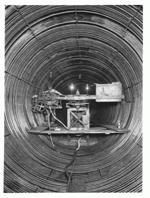
15. Die als halbe Ringe in den obern Druckstollen eingebrachten 22 Milimeter Rundeisenarmierung werden am Ort mittels spezialkonstruierter Stumpfschweissmaschine elektrisch verbunden
