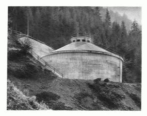
17. ZYLINDRISCHER WASSERBEHÄLTER DES WASSERSCHLOSSES REMPEN
