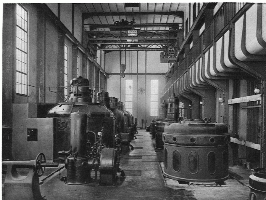
43. MASCHINENSAAL REMPEN / INNERES Vier Generatoren und vier Pumpenmotoren, wovon zwei montiert
