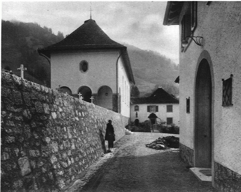
56. NEU-INNERTHAL / EINGANG ZU SCHULHAUS, KIRCHE UND PFARRHAUS Architekten Müller & Freytag
