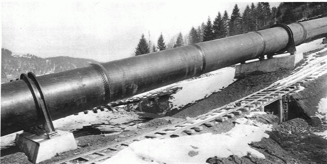
19. DRUCKLEITUNG REMPEN Durchmesser 2,40 m
