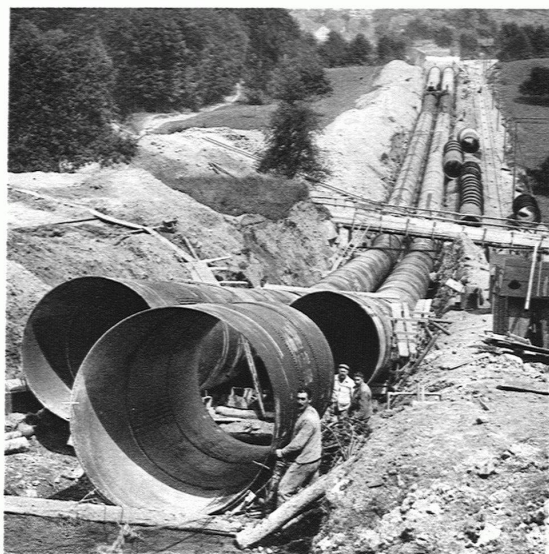
23. DRUCKLEITUNG SIEBNEN Verlegen der 2,50 m weiten Rohre in den Boden
