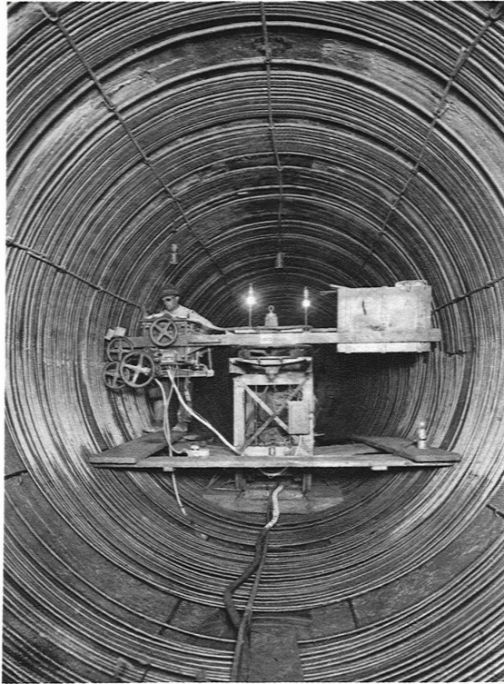
15. Die als halbe Ringe in den oberen Druckstollen eingebrachten 22 Millimeter Rundeisenarmierung werden am Ort mittels spezialkonstruierter Stumpfschweissmaschine elektrisch verbunden
