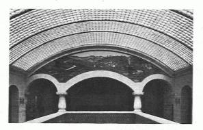
Abb. 3. Keppler-Glasbetongewölbe über der Halle des Rathauses in Le Locle, 70 m².
