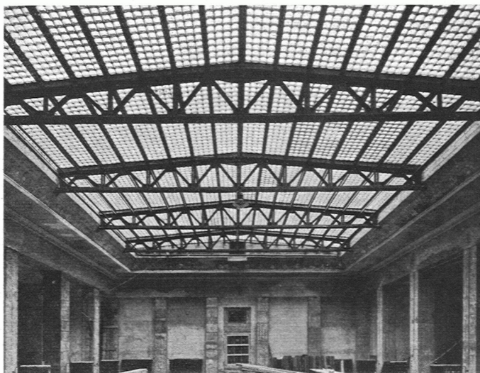
Abb. 2. Untersicht des Keppler-Glasbetondaches über der Kassenhalle der Schweiz. Volksbank in Zürich, 200 m 2 .
