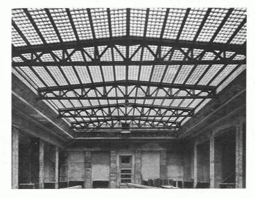
Abb. 2. Untersicht des Keppler-Glasbetondaches über der Kassenhalle der Schweiz. Volksbank in Zürich, 200 m².
