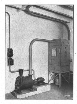
Abb. 3. Ansicht des Filters (rechts) und des elektrisch angetriebenen Zentrifugalventilators (links) einer Sulzerschen Entstaubungsanlage.
