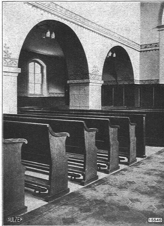
Kirche Oberwinterthur mit Sulzer-Elektro-Dampfheizung
