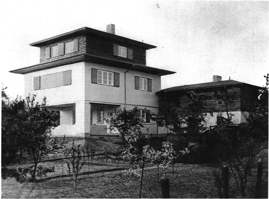
SOMMERHAUS KYSER, WERDER A.D. HAVEL Heller Naturputz, dunkelbraune Stulpschalung, Ruberoiddach, bunte Fensterläden und Gesimse
