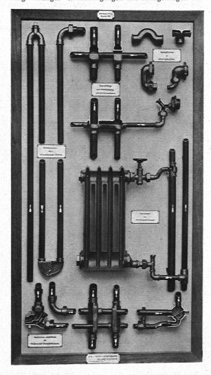
Abb. 2. Schaukasten für die Anwendung von Weichguss-Fittings Marke +GF+ in der Zentralheizungsindustrie, aufgestellt im Hygienemuseum der Eidgen. Techn. Hochschule
