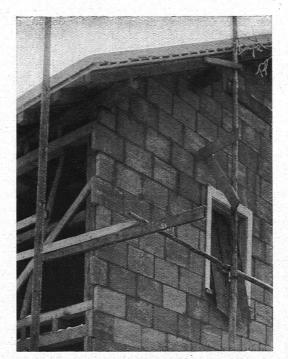
Abb. 3. Mit Weltonplatten verkleideter Riegelbau. mer 1925 von der Firma Weibel & Co., Gloten-Sirnach für den Platz Zürich berechnet.
