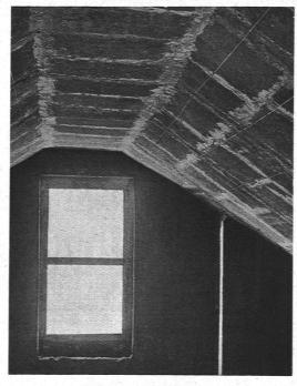
Abb. 2. Mit Weltonplatten ausgebautes Dachgeschoss.
