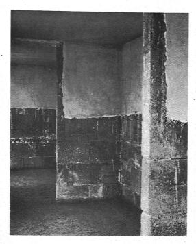
Abb. 1. Welton-Scheidewände und Mauerverkleidung, oben mit Weißstrich versehen, unten zur Aufnahme des Täfers bereit.
