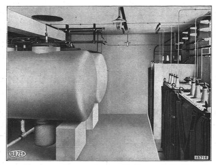
Elektro-Warmwasserspeicher von 1200 kW Einphasenwechselstrom, 1000 Volt, 16<sup>2</sup>/<sub>3</sub> Per/sec. in der S.B.B.-Werkstätte Bellinzona.
