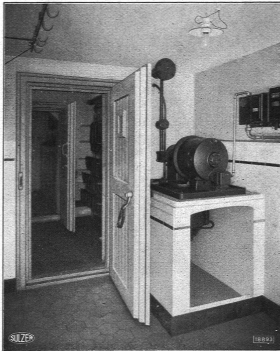
Abb. 8. Metzgereikühlanlage mit »Frigorotor« Sulzer.
