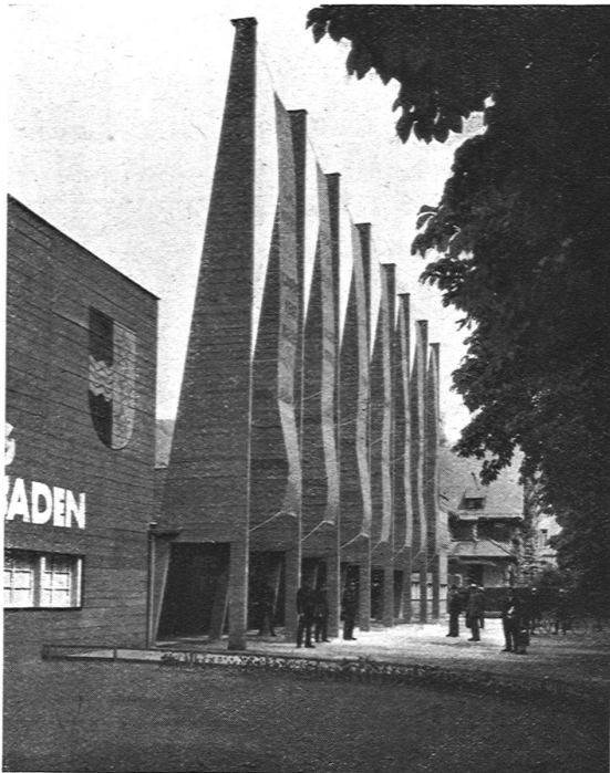
EINGANG AN DER PARKSTRASSE Phot. Zipser
