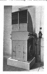
Abb. 3. In der Flugzeughalle in Dübendorf aufgestellte Luftheizapparate.
