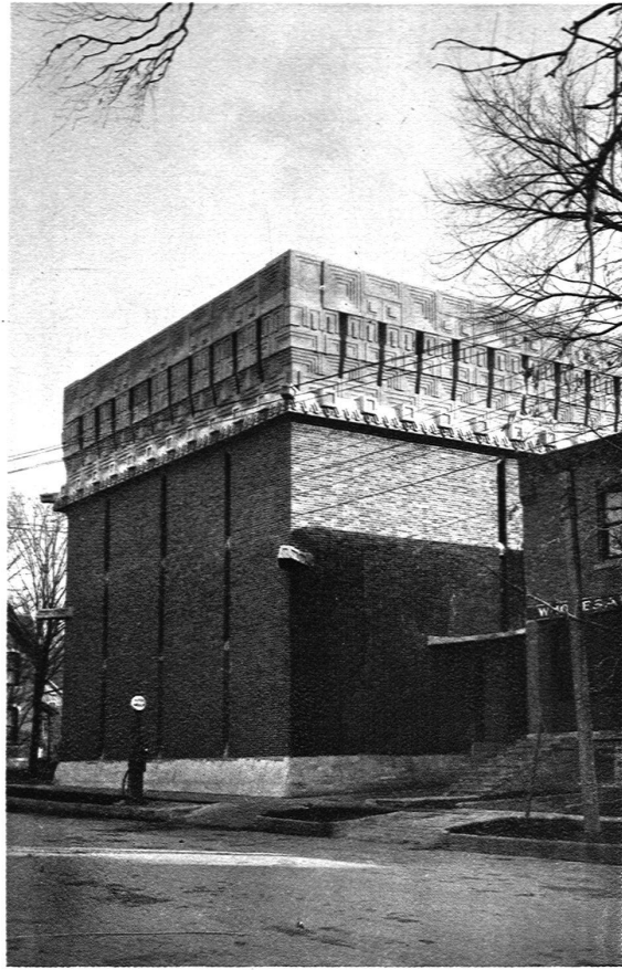
MAGAZIN IN RICHLAND CENTRE, WISCONSIN Ansicht der Schmalseite
