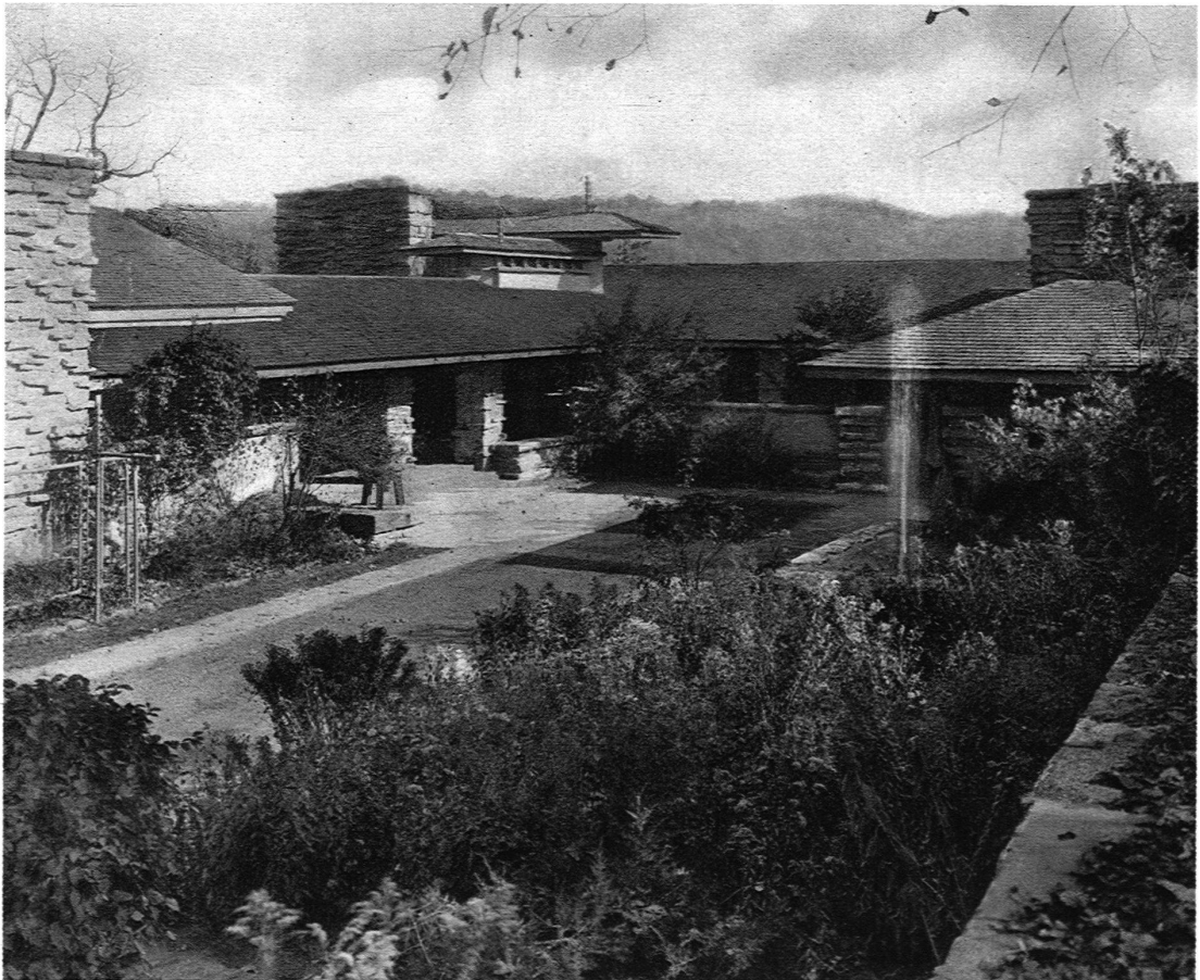
LANDHAUS WRIGHT Hofansicht nach Südost
