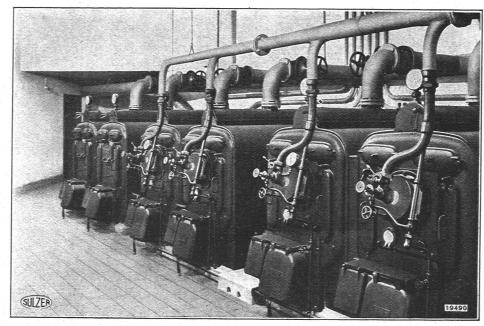
4 Sulzer-Warmwasserheizkessel mit zusammen 73 m² Heizfläche, ausgerüstet mit Oelfeuerung.
