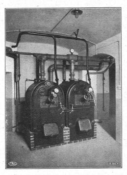
2 Sulzer-Gliederkessel von je 9 m² Heizfläche, ausgerüstet mit Oelfeuerung.
