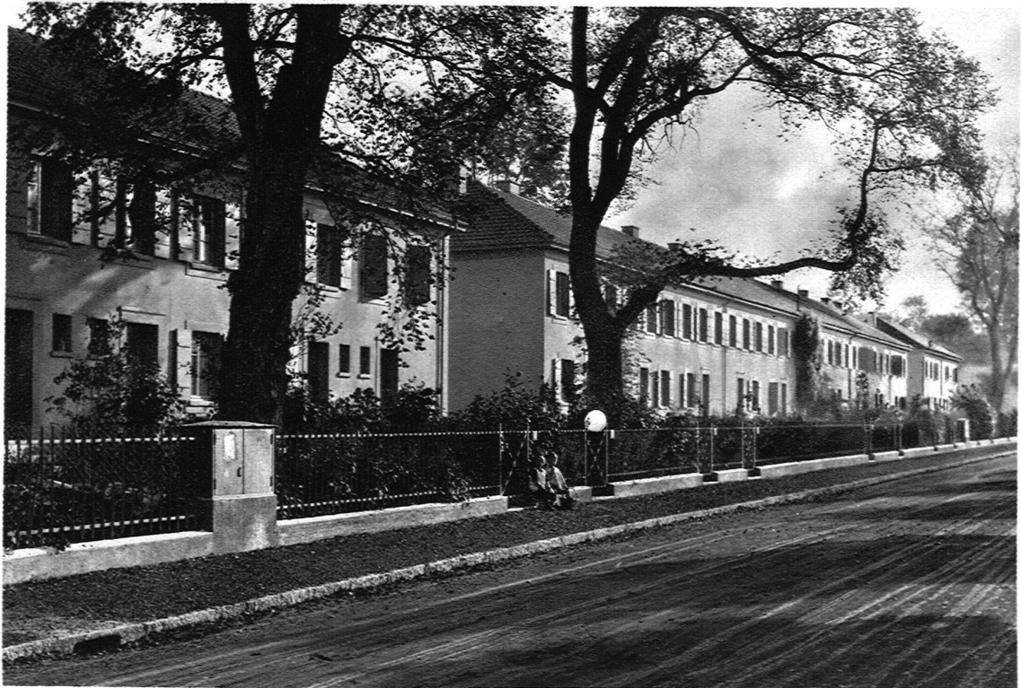
FIG. 8 FAÇADES SUR CHEMIN DES SPORTS Phot. Boissonnas
