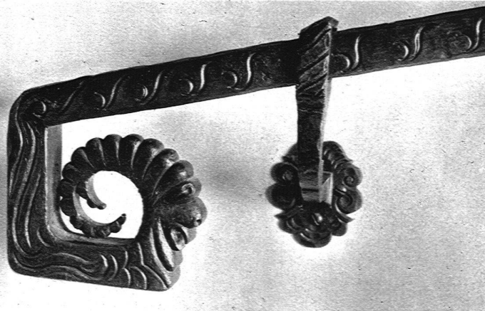
ABB. 11 TREPPENHANDLAUF, UNTERER ABSCHLUSS (SCHMIEDEEISEN)
