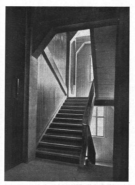
Abb. 2. Patenttreppe in der Stickerei Eugster, Altstetten (Rheintal), auf Eisenbeton-Rahmen montiert, als feuersichere Anlage in bestehenden Holzbau eingebaut.
