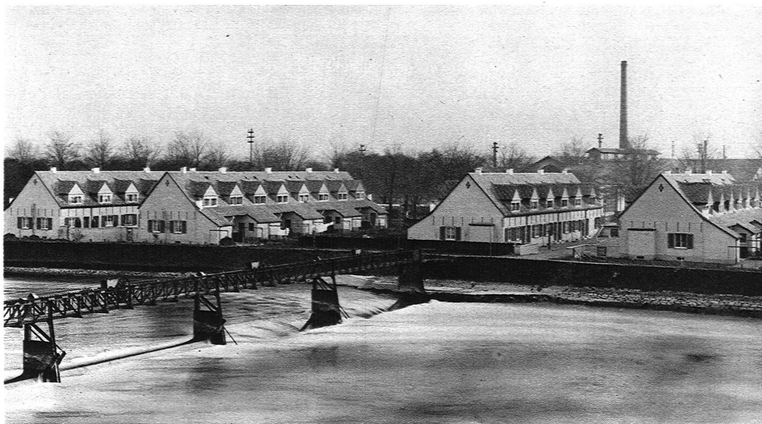
ABB. 5 WOHNKOLONIE AN DER HARDTURMSTRASSE, ZÜRICH Ausgeführt 1924 von Architekt Prof. Hans Bernoulli B. S. A., Basel GESAMTANSICHT VON NORDWESTEN Phot. J. Meiner, Zürich
