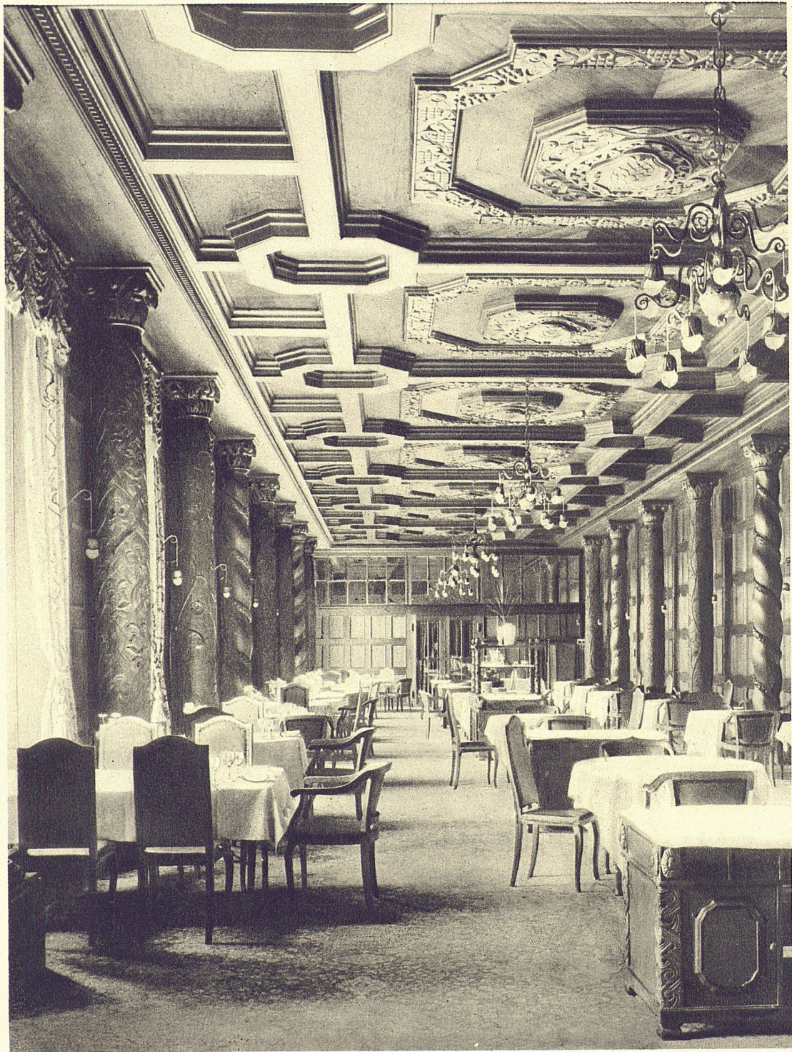
RESTAURANT IM HOTEL SUVRETTAHAUS ST. MORITZ HEIZUNG und LÜFTUNG ausgeführt von GEBRÜDER SULZER, AKTIENGESELLSCHAFT, WINTERTHUR
