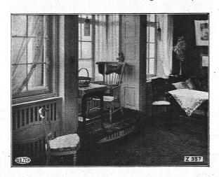
Abb. 12. Heizkörperaufstellung in den Fensternischen und dem Erker eines Wohnzimmers. Der Erkerfussboden wird durch einen Doppelboden und die darunter durchströmende Raumluft warm gehalten.
