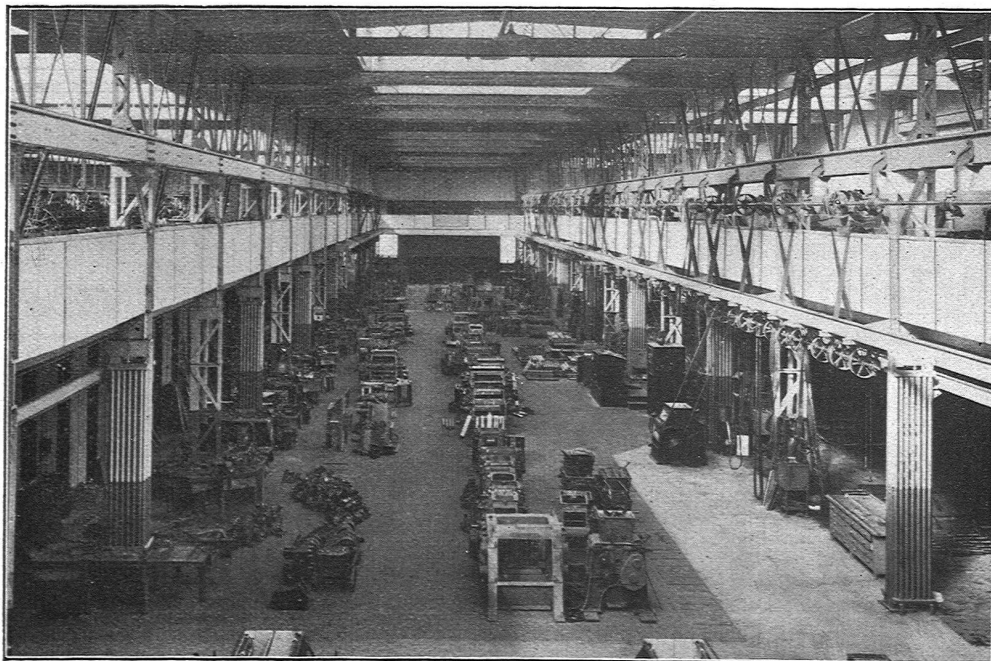
Abb. 6. Aufstellung von Rohrharfen an den Fachwerkträgern in der Maschinenfabrik Rauschenbach A.-G., Schaffhausen Ausführung der Firma Gebrüder Sulzer A.-G.
