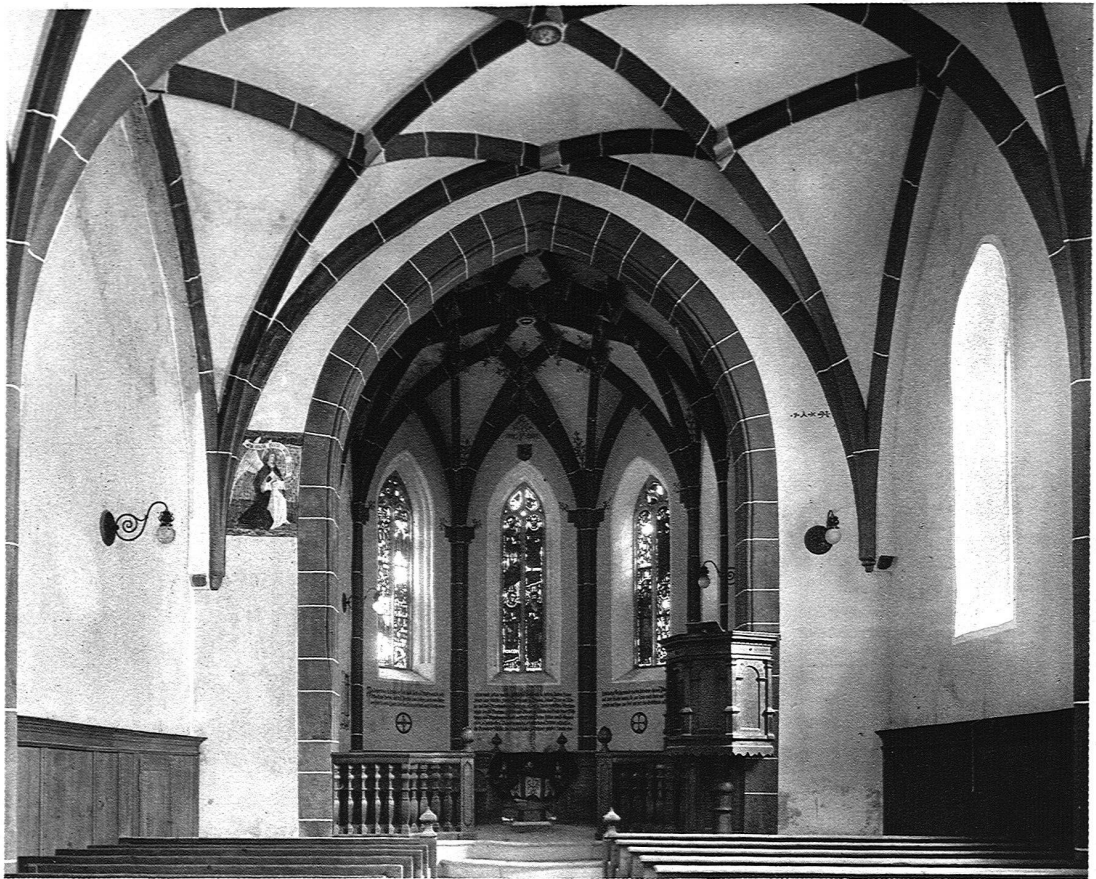
ABB. 15 CHOR DER KIRCHE VON KÜBLIS, RENOVIIERT VON DEN ARCHITEKTEN SCHÄFER UND RISCH B. S. A., ZÜRICH-CHUR Phot. Lang, Chur
