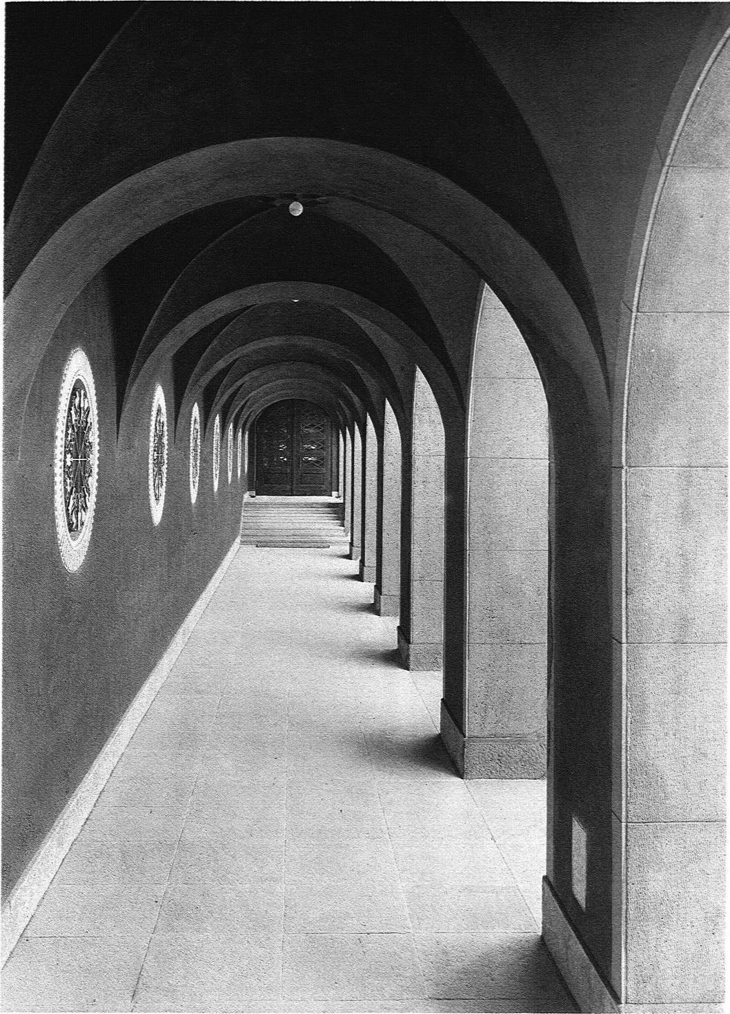
ABB. 8 EINGANGSHALLE Phot. E. Linck
