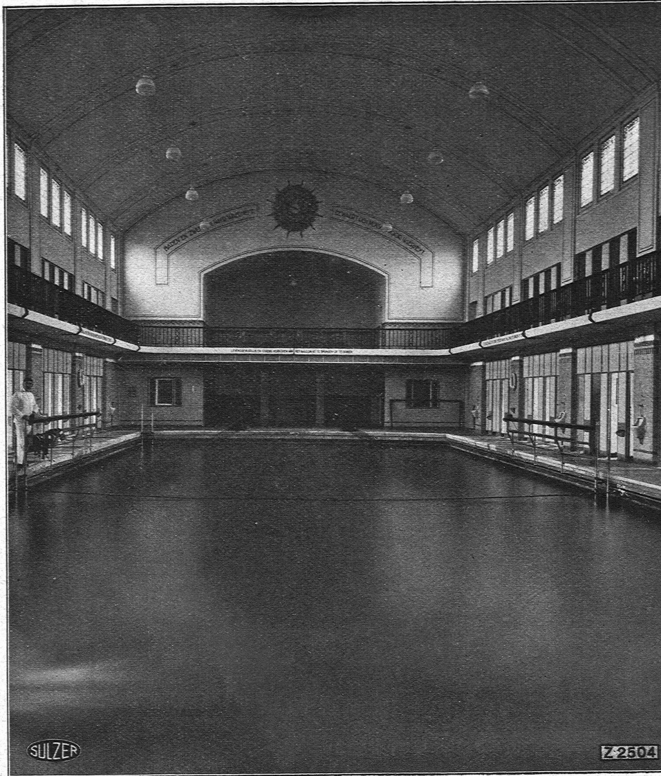
Schwimmbassin von 415 m 3 Inhalt im Schwimmbad Bloemendaal (Holland)
