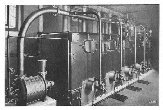
4 gusseiserne Gliederkessel mit zus. 64 m² Heizfläche, ausgerüstet mit Oelfeuerung.
