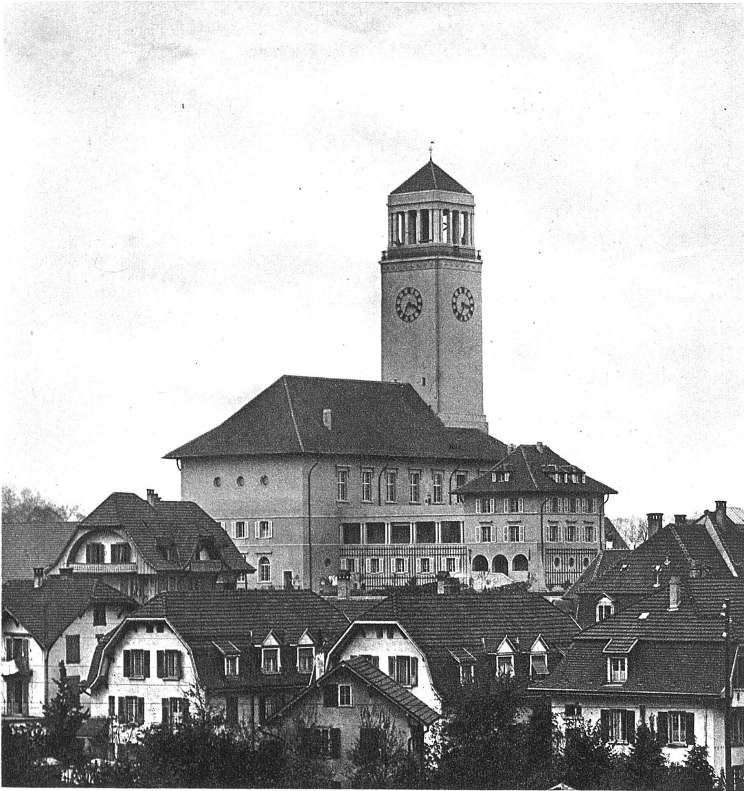
ABB. 2. GESAMTANSICHT VON SÜDEN
