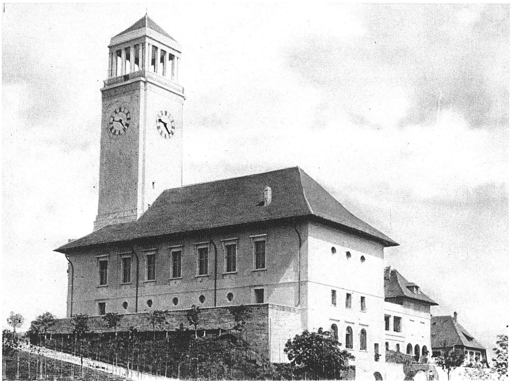
ABB. 4. GESAMTANSICHT VON WESTEN
