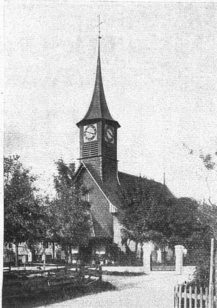
Helm, Zifferblattwände und äussere Wand- verkleidung in Eternit- Doppeldeckung, kupferbraun
