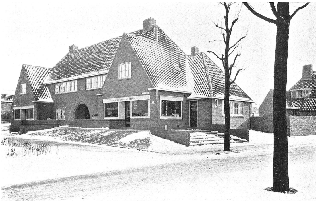
Stadtbaumeister W. M. Dudok, Hilversum. Kolonie Hilversum. Ansicht einer Wohnhausgruppe aus Standpunkt D. (Siehe Übersichtsplan S. 210)
