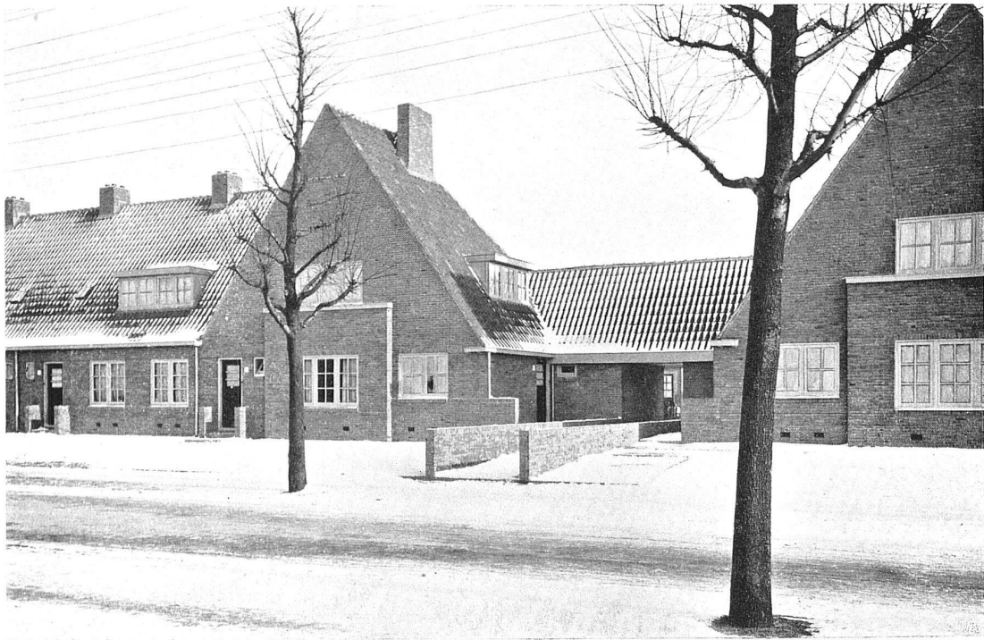
Stadtbaumeister W. M. Dudok, Hilversum. Straße in der Kolonie Hilversum. Ansicht aus Standpunkt F. (Siehe Übersichtsplan S. 210)
