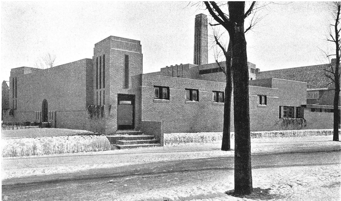
Stadtbaumeister W. M. Dudok, Hilversum. Bad in der Kolonie Hilversum. Ansicht aus Standpunkt A. (Siehe Übersichtsplan S. 210)
