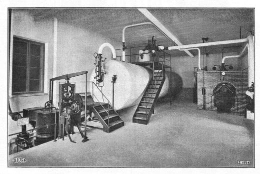
DAMPFSPEICHER UND ELEKTROKESSEL IN DER BAUMWOLLSPINNEREI U. WEBEREI WETTINGEN (DREHSTROM VON 2100 VOLT / LEISTUNG 300 KW / ARBEITSDRUCK 14 ATM. / INHALT D. SPEICHERS 32 000 L) DER ELEKTRISCHE TEIL DER ANLAGE WURDE VON DER A.-G. BROWN, BOVERI & CIE GELIEFERT.
