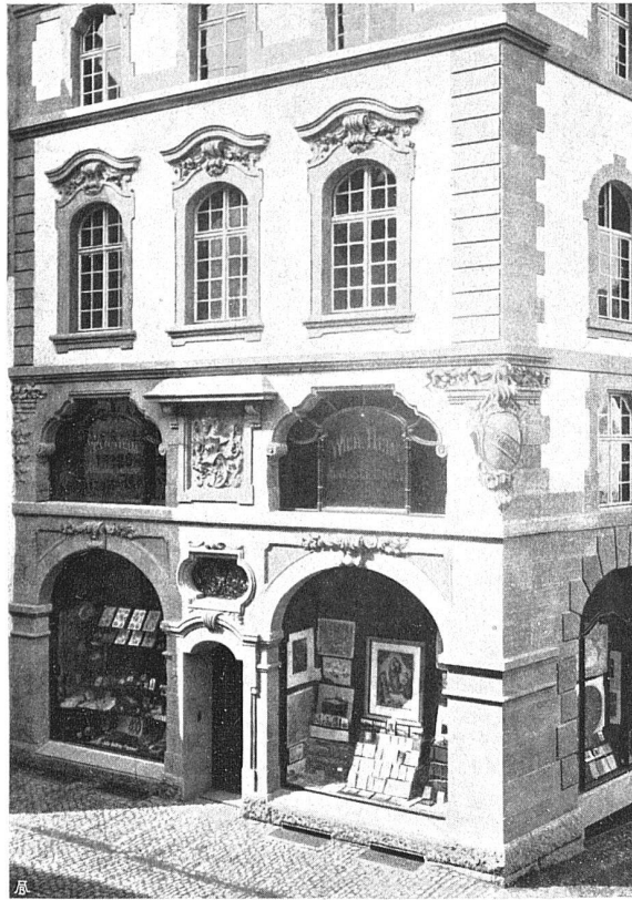
Geschäftshaus an der Freiestraße, Basel
