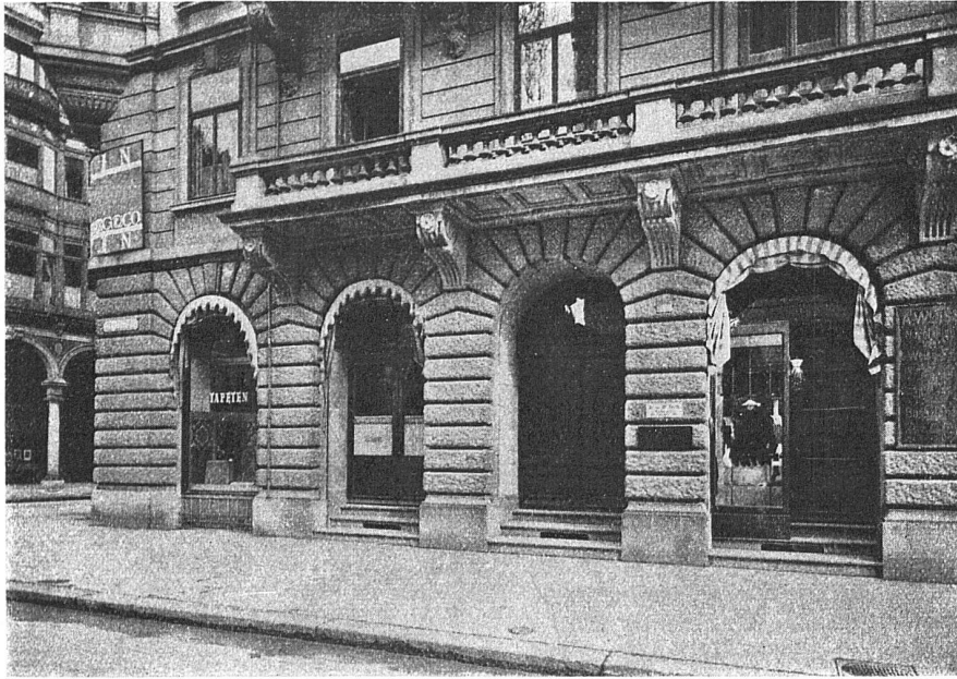
Geschäftshaus beim Geiserbrunnen, Bürkliplatz, Zürich
