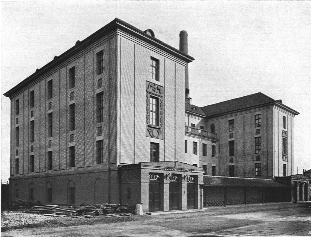
Bad- und Speiseanstalt der Chemischen Fabrik vorm. Sandoz A.-G. Basel Professor Hans Bernoulli, Architekt B. S. A., Basel. Gesamtansicht
