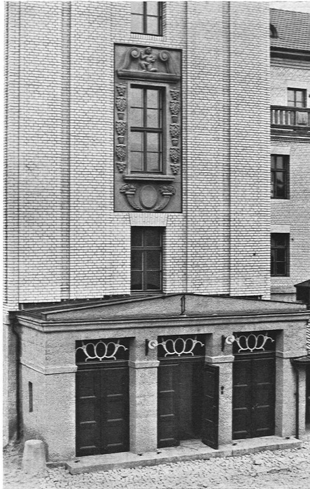
Bad- und Speise- anstalt der Chemi- schen Fabrik vorm. Sandoz A.-G. Basel Eingang 1
