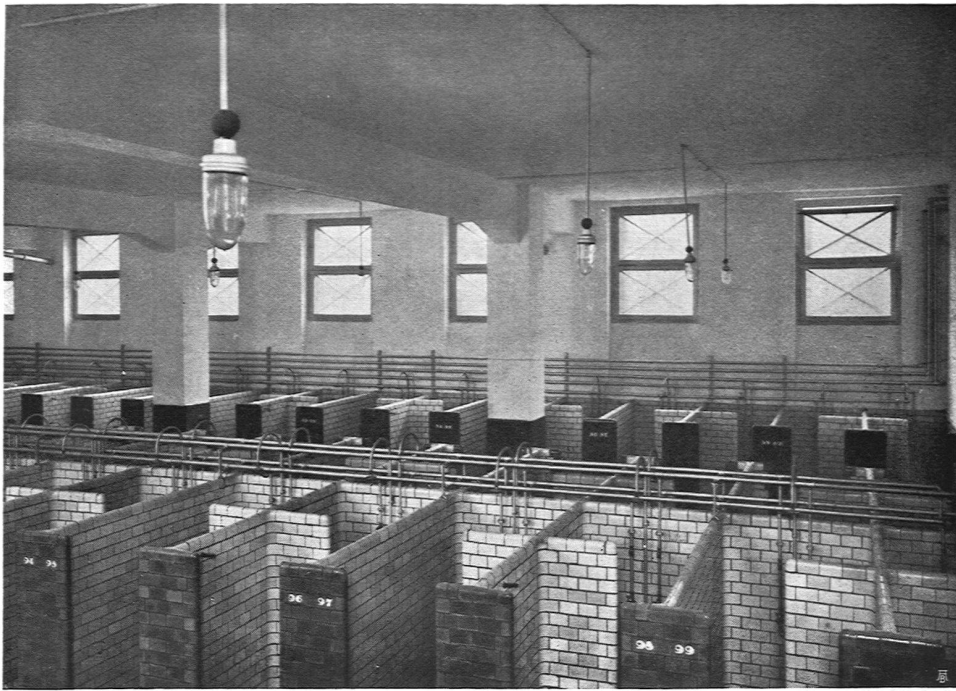
Duschenraum I, Übersicht, Untergeschoß der Bad- und Speiseanstalt
