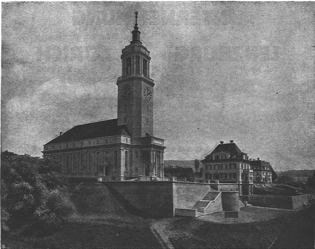
NEUE KIRCHE UND PFARRHAUS IN ZÜRICH-FLUNTERN
