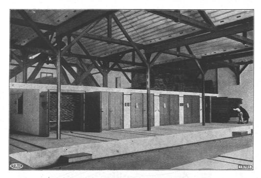
HOLZTROCKNUNGS-ANLAGE BEI DER SCHWEIZ. INDUSTRIE-GESELLSCHAFT NEUHAUSEN, WERK RAFZ. 6 TROCKENKAMMERN MIT EINER AUFNAHMEFÄHIGKEIT VON JE 17 m³ HOLZ. 1 LANGHOLZ-TROCKEN-KAMMER (IN DER ABBILDUNG NICHT SICHTBAR) FÜR 24 m³ HOLZ
