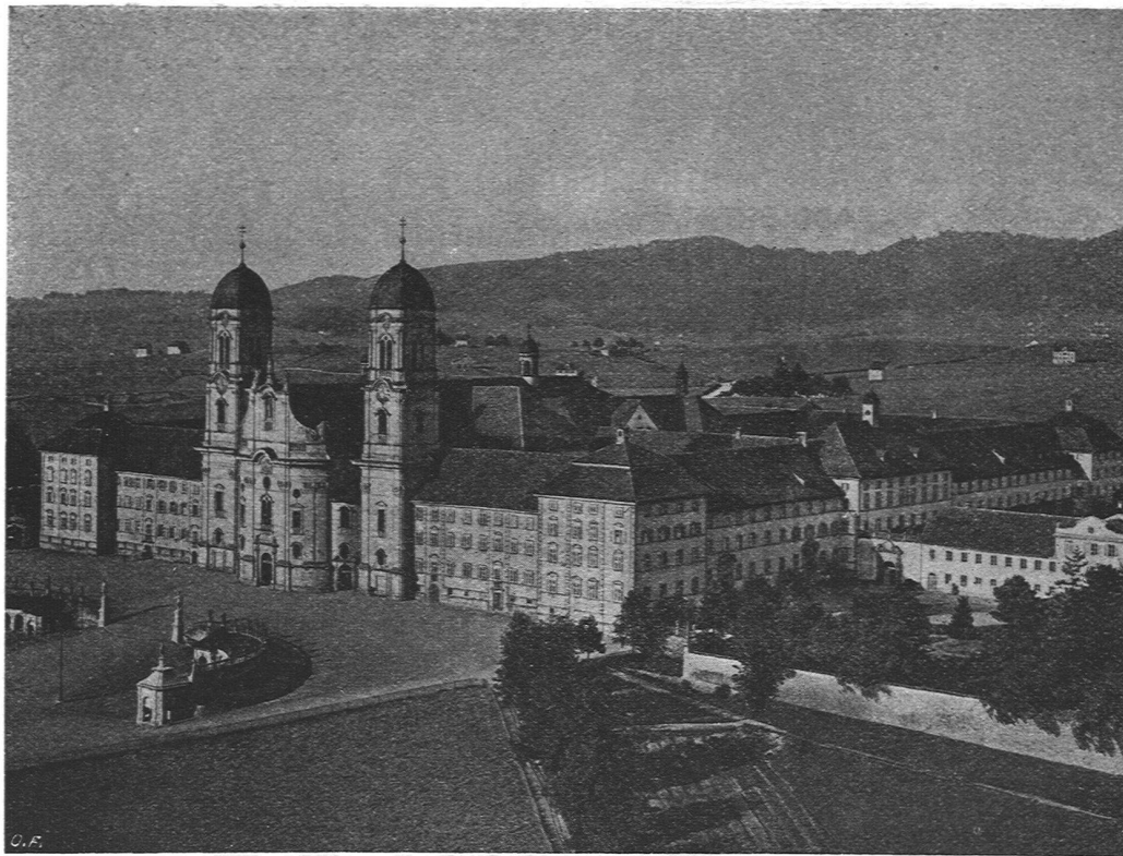
KLOSTER EINSIEDELN, FERN-WARMWASSERHEIZUNG IN SÄMTLICHEN GEBÄUDEN. DAMPFKOCKKÜCHEN-ANLAGE
