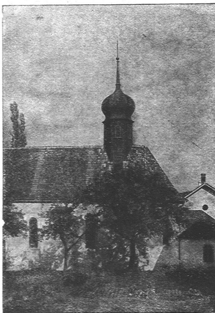
KAPELLE SPREITENBACH (AARG.), DACHREITER IN ETERNIT, GESCHLAUFTE DECKUNG, KUPFERBRAUN
