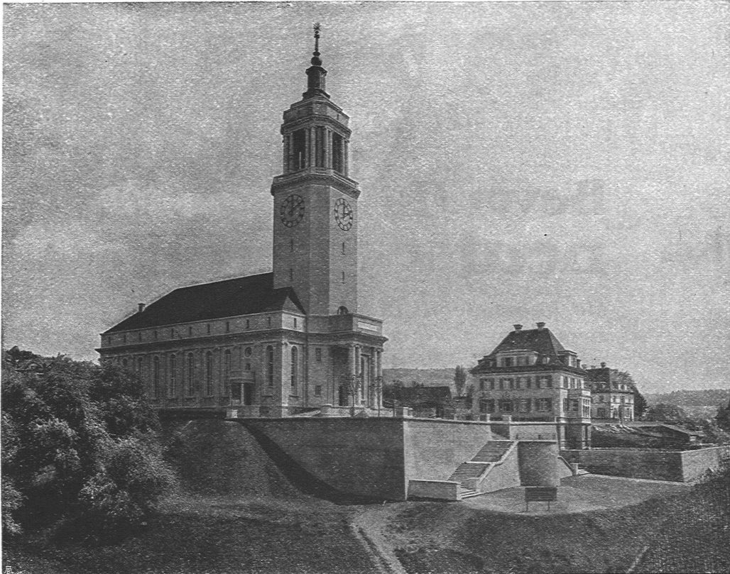
NEUE KIRCHE UND PFARRHAUS IN ZÜRICH-FLUNTERN
