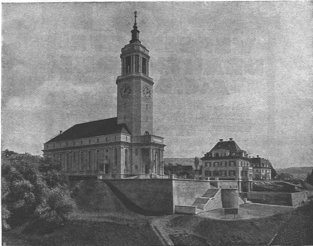
NEUE KIRCHE UND PFARRHAUS IN ZÜRICH-FLUNTERN
