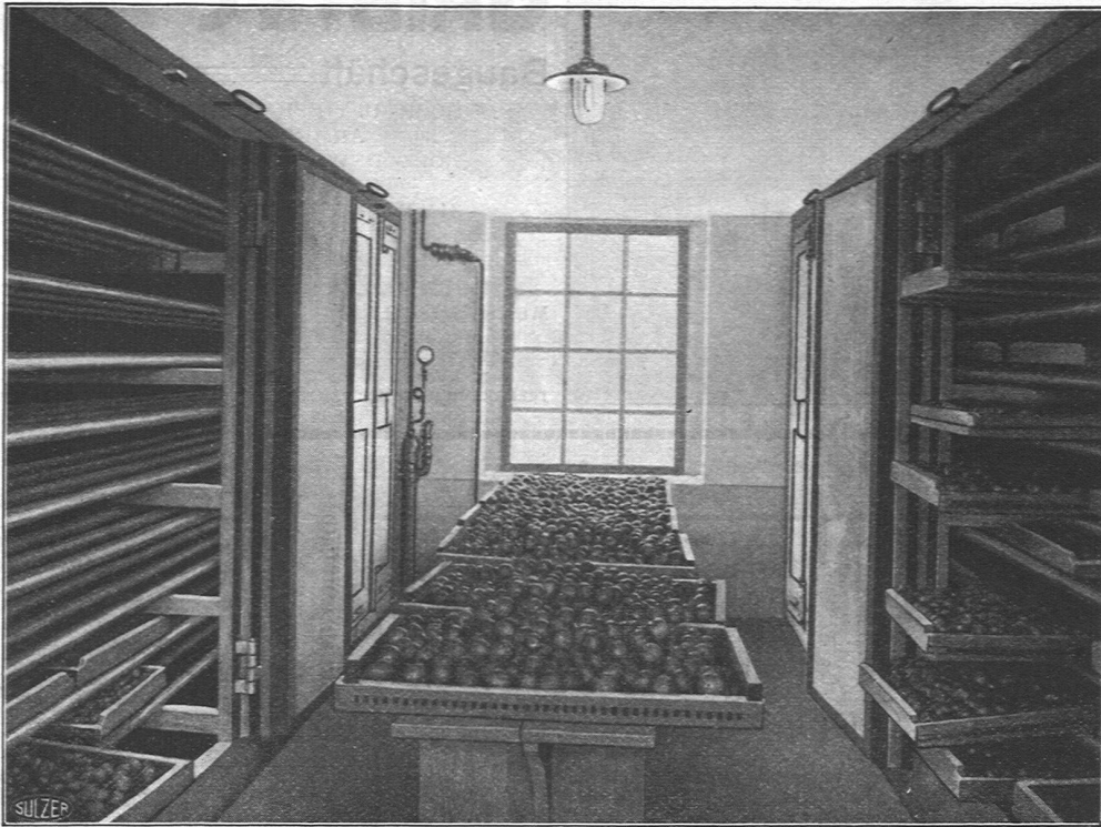
DÖRRANLAGE FÜR OBST IM GASWERK ST. MARGRETHEN DURCH ABWÄRME BETRIEBEN
