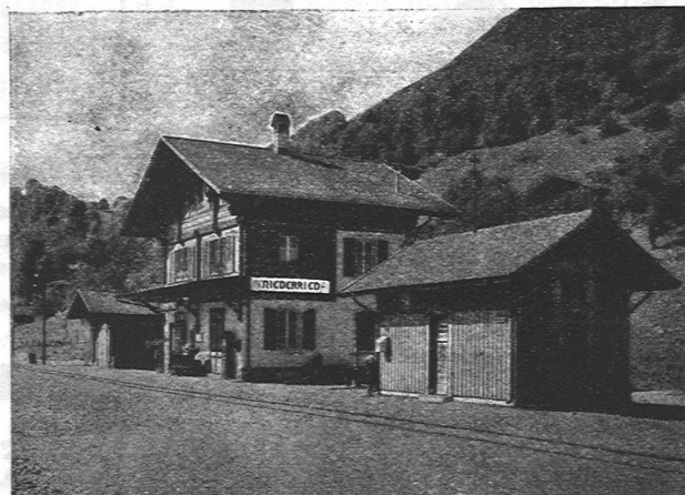
STATION DER BRIENZERSEEBAHN, ETERNIT-DOPPELDACH, KUPFERBRAUN
