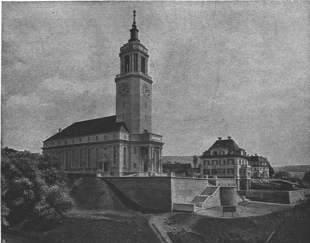
NEUE KIRCHE UND PFARRHAUS IN ZÜRICH-FLUNTERN
