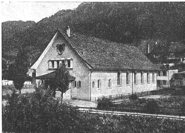
TURNHALLE IN GLARUS ETERNIT-DOPPELDACH, SCHWARZ ENGOBIERT
